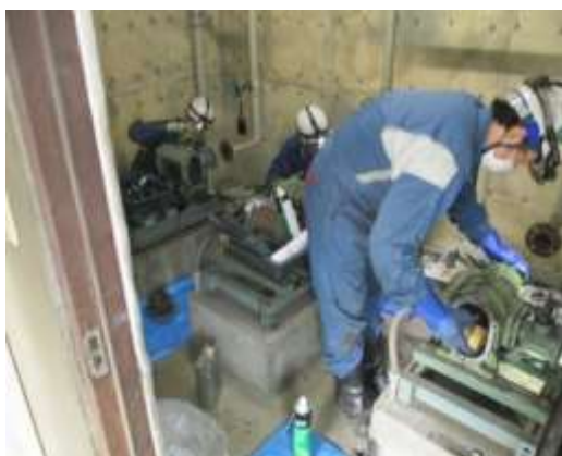
オーバーホール作業中
